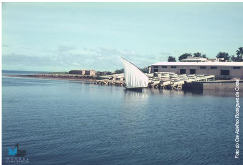
O plano inclinado de Porto Amélia em construção
