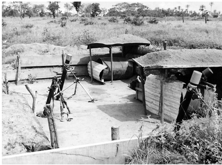
Cubisseco - Abrigo de morteiro na Tabanca Nova
