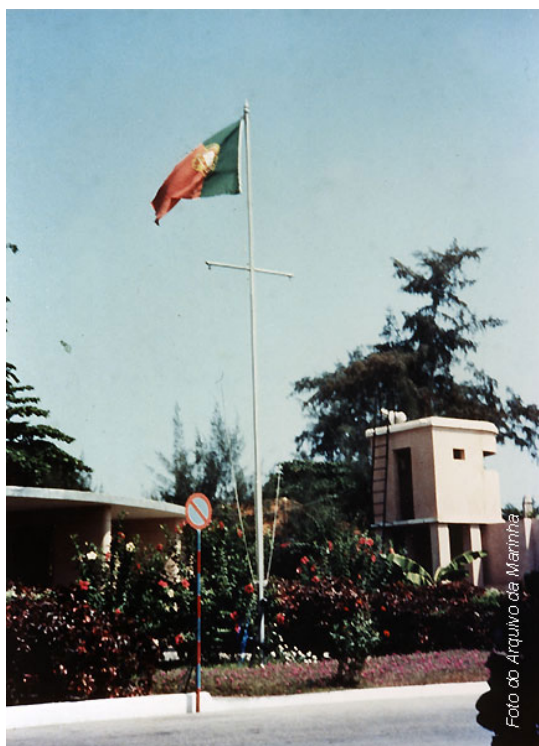
Luanda - Instalações Navais da Ilha do Cabo
